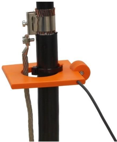
Obr. 9: Instalace proudového čidla
